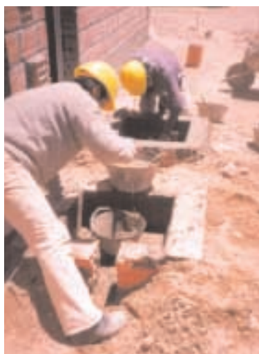
Trabajando con mortero de cal
